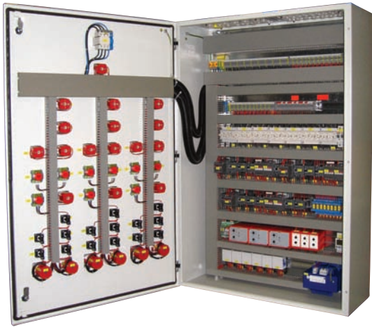
Schaltschrank zur Ansteuerung einer Klimaanlage Switchboard for controlling air conditioning system
