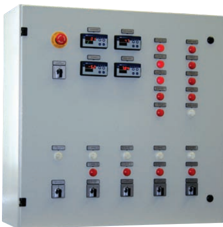
Schaltschrank zur Ansteuerung einer Grundwasserreinigungsanlage Switchboard for controlling ground-water cleaning device
