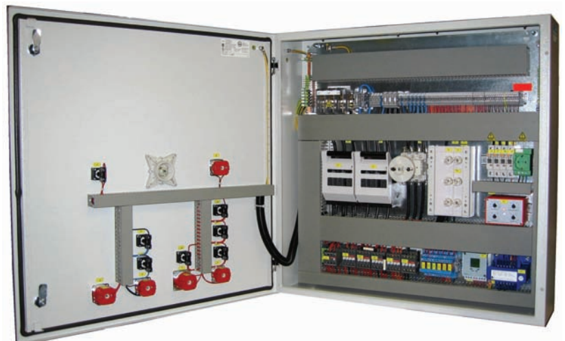
Schaltschrank zur Ansteuerung einer Getreidemühle Switchboard for controlling a flour mill
